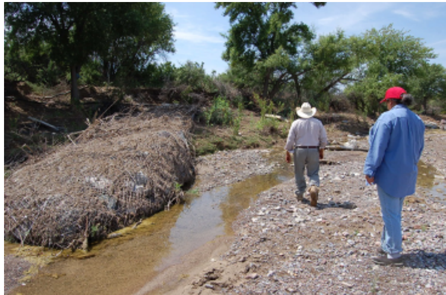
Imagen 9. Gaviones elaborados para la conservación del suelo y el agua en el ejido Nuevo Lajitas. Fotografía: Ana Ivonne Rodríguez Anchondo, abril de 2017.
