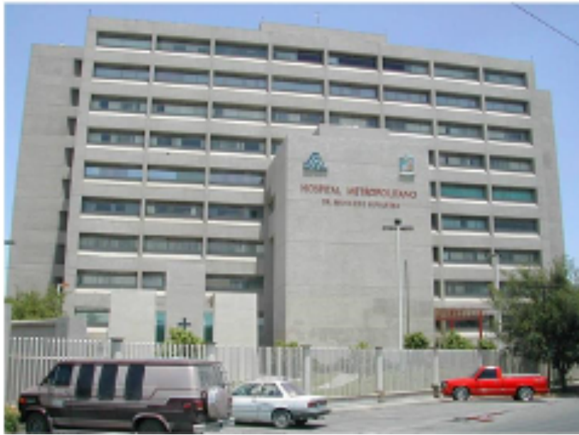
Figura 5. Vista principal del Hospital Metropolitano "Dr. Bernardo Sepúlveda" en el municipio de San Nicolás de los Garza, Nuevo León, México. Fuente: http://www.saludnl.gob.mx/drupal/hospital-metropolitano
