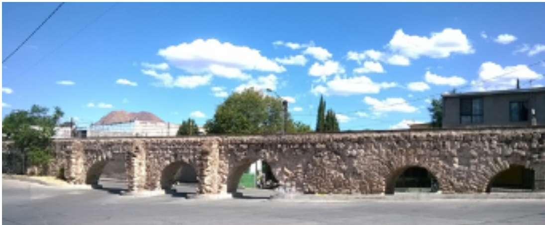
Fig. 2. Tramo del acueducto en el que se aprecian algunos arcos tapados y rebajados para el paso de automóviles. Foto, América Malbrán Porto, 2018.
