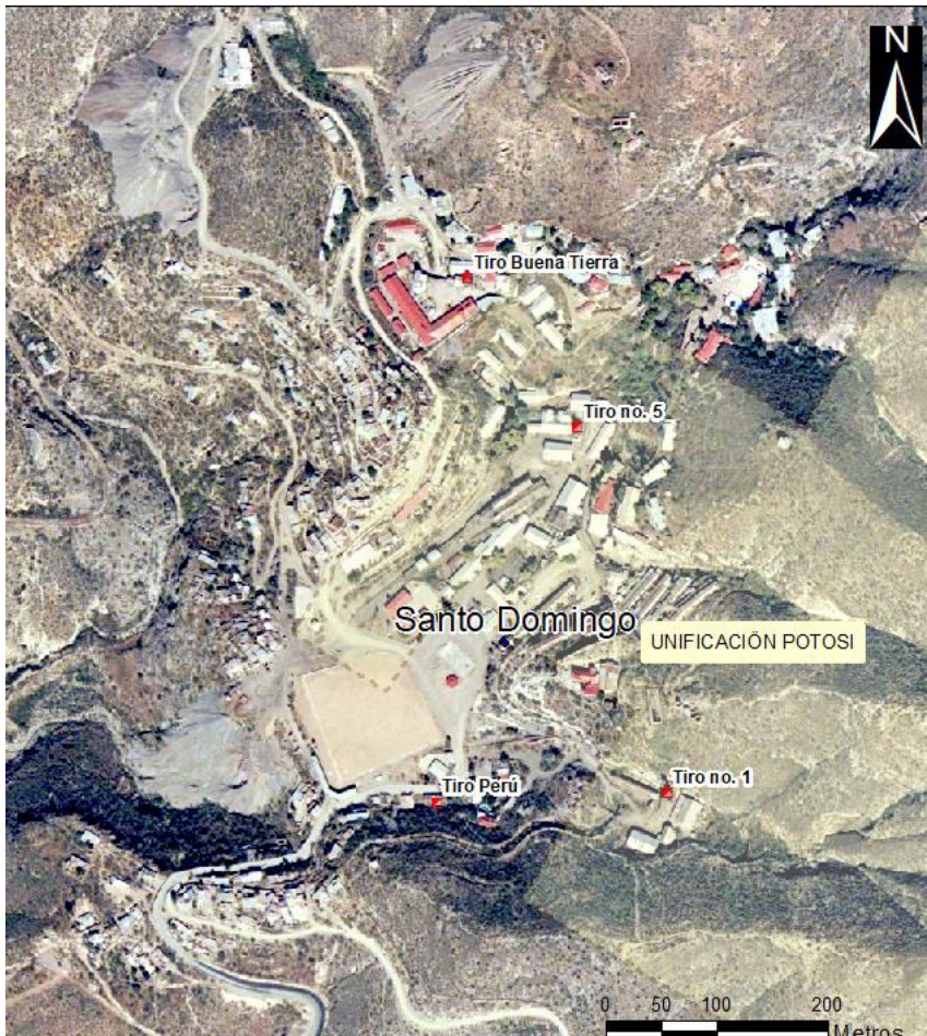
Figura 2. Instalaciones en superficie de El Potosi Mining Company actualmente formando parte de la concesión minera denominada 'Unificación Potosi'.
