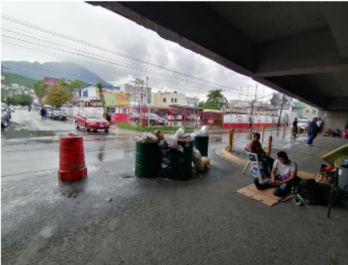
Figura 6. Condiciones climáticas extremas, en los bajos del puente de la avenida "Dr. José Eleuterio González" frente al Hospital Universitario en Monterrey, Nuevo León, México. Fecha: 17 de septiembre de 2020. Fuente: José Antonio González Espinoza.
